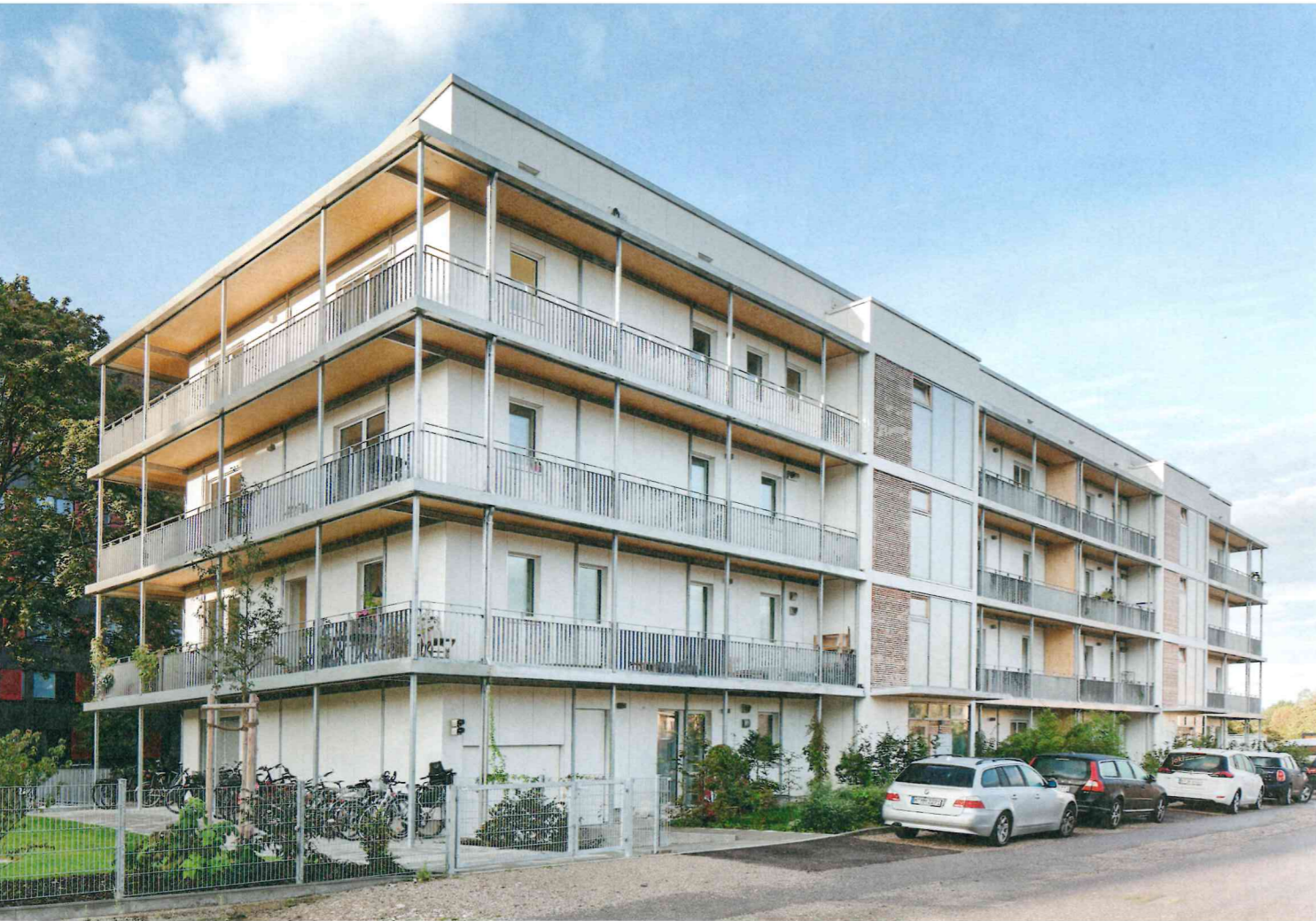
▲ Umweltfreundlichkeit und Sparsamkeit stimmen: Das Münchner Gebäude wurde durch das Passivhaus-Institut in Darmstadt zertifiziert
