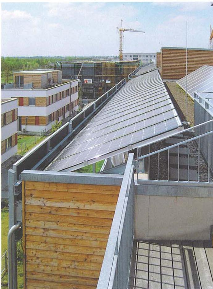
Das Nullenergiekonzept von NEST solaR2 basiert auf zwei Grundlagen: dem Passivhausstandard für alle Gebäude und der Bereitstellung der verbleibenden Restenergie durch erneuerbare Energieträger. Die U-Werte der geschlossenen Hüllflächen liegen zwischen 0,10 W/m<sup>2</sup>K (Außenwände der Reihenhäuser) und 0,16 W/m<sup>2</sup>K (Bodenplatte des Geschosswohnungsbaus). Die Fenster erreichen ebenfalls passivhaus-taugliche Werte von 0,5–0,6 W/m<sup>2</sup>K (Glas) und 0,76 W/m<sup>2</sup>K (Rahmen).
